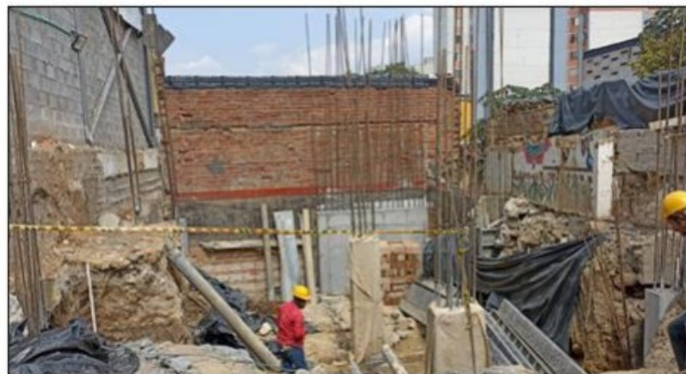
Ilustración 9 Vaciado y curado de columnas y pantalla en área del sótano
