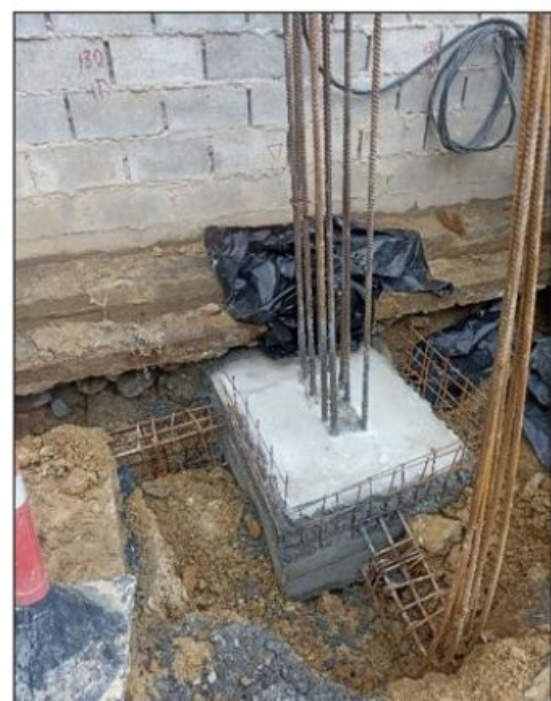
Ilustración 9 Vaciado y curado de columnas y pantalla en área del sótano
